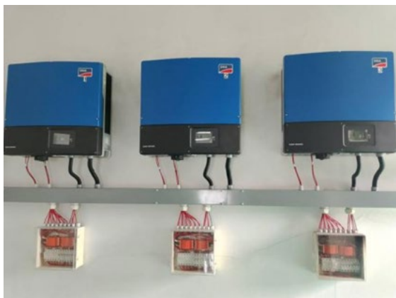
ภาพการติดตั้ง Solar Rooftop ขนาด 96 กิโลวัตต์ (อาคาร 7)
