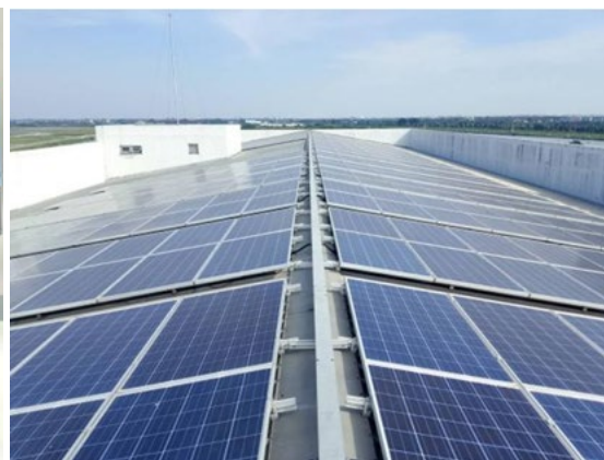
ภาพการติดตั้ง Solar Rooftop ขนาด 96 กิโลวัตต์ (อาคาร 7)
